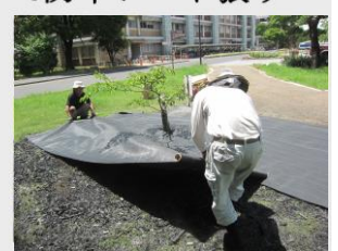
e防草シート張り
